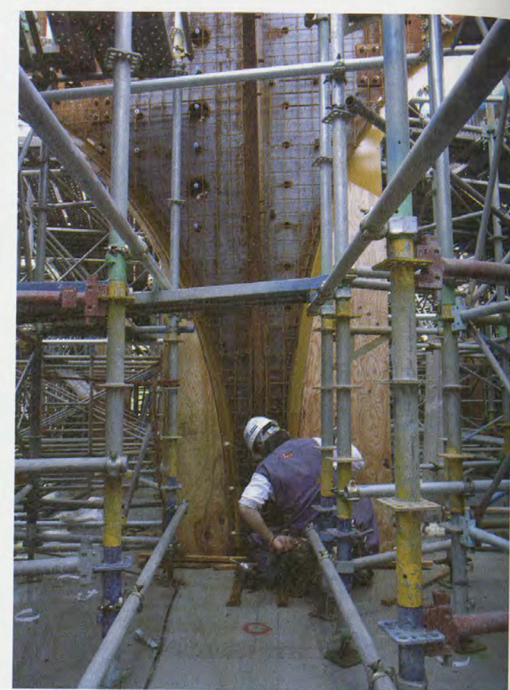
中央部に鉄板でアーチをつくり、その両サイドにコンクリートを打って、厚さ20cmのスレンダーな架構を実現させた。地下に免震構造を採用している The arches in the center were made with iron plates and concrete. The structure is 20cm thick. It uses a seismic structure underground.
