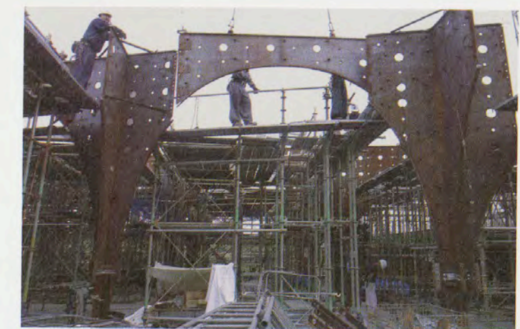
中央部に鉄板でアーチをつくり、その両サイドにコンクリートを打って、厚さ20cmのスレンダーな架構を実現させた。地下に免震構造を採用している The arches in the center were made with iron plates and concrete. The structure is 20cm thick. It uses a seismic structure underground.
