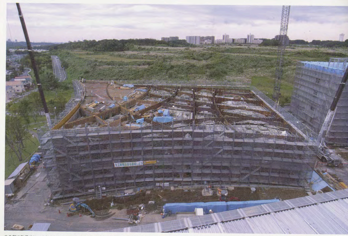
中央部に鉄板でアーチをつくり、その両サイドにコンクリートを打って、厚さ20cmのスレンダーな架構を実現させた。地下に免震構造を採用している The arches in the center were made with iron plates and concrete. The structure is 20cm thick. It uses a seismic structure underground.
